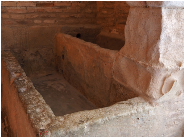
Détail de la chambre des vannes. © CMN
