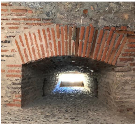
Canonnière située dans le mur de la pièce voûtée située à l'entrée du réduit. © CMN
