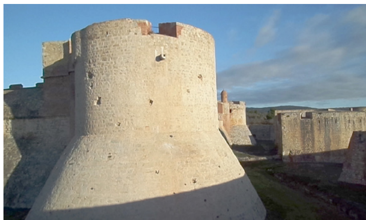
Tour d'angle sud-est : des impacts des boulets de canons sont encore visibles. © CMN
