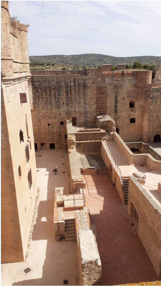
Terrasse panoramique sur le réduit donnant une vue d'ensemble de la place d'armes et du donjon. © CMN
